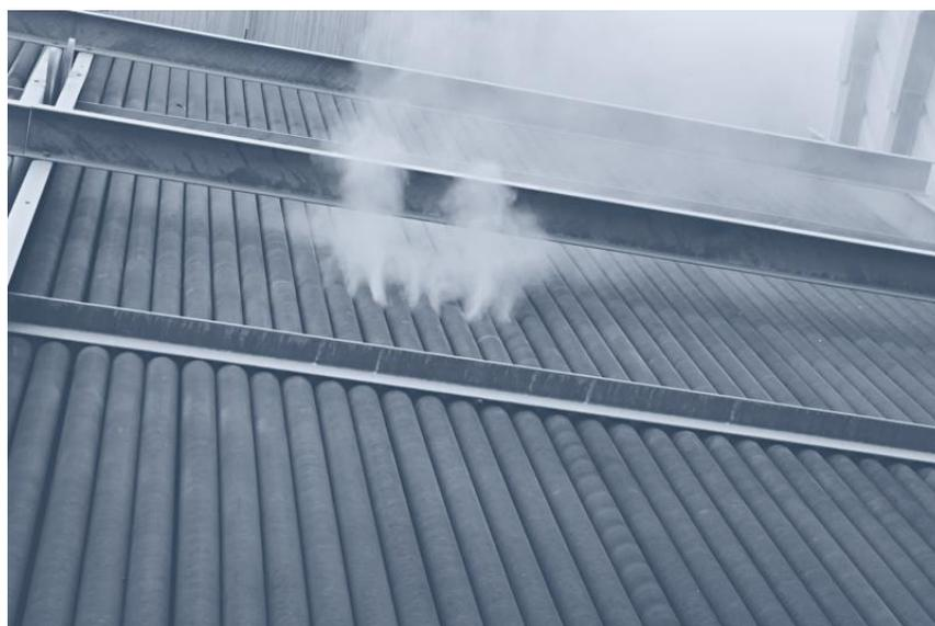
Dans le cadre d'un programme de maintenance régulier et dans le but de récupérer un échange thermique convenable sur ce type d'équipements, CTP environnement a proposé de nettoyer les tubes à ailettes via son procédé Decamex®.
